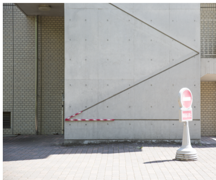
「この壁を作ったときも、溝の部分に角材を当ててコンクリを流したはず」(角材、塗料)
